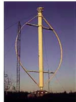
Hay que tener en cuenta que, para aportar energía a la red eléctrica, la corriente debe ser generada de forma sincrónica con la red (50 Hz en Europa). Esto obliga a un sofisticado sistema de sincronización y a la incorporación de grandes cajas multiplicadoras que aumenten la velocidad de giro entre el eje de la hélice y el eje de giro del generador eléctrico.
