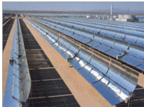
**Figura 3-10: Fotografía del campo de concentradores de una planta CPC**
