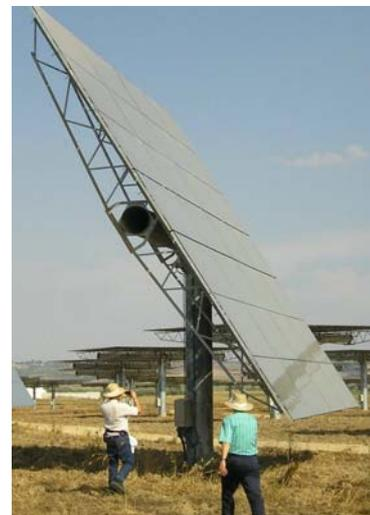
**Figura 3-12: Helióstato de la planta PS10 de Solucar.**
