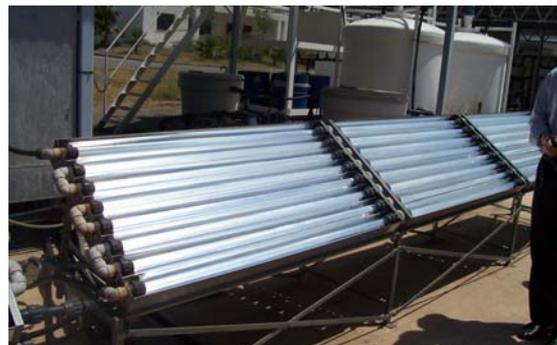
**Figura 2-12: Sistema de desinfección fotocatalítica**
